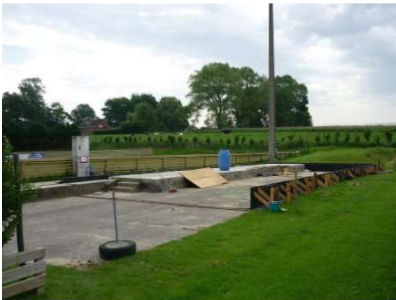
De eerste voorbereidingen zijn al begonnen
